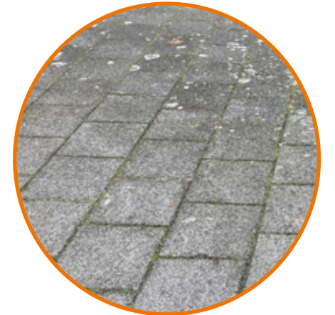
Hergebruik 30x30 tegels - trottoir
