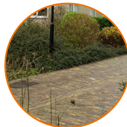
Hergebruik gebakken steen gemixt met een gele steen, ter aansluiting zuidelijke Sionstraat. Opvangen hemelwater - v-profiel met molgoot.
