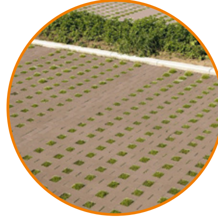
Groen fietsparkeren Infiltratie hemelwater (met gebakken steen (hergebruik keiformaat))
