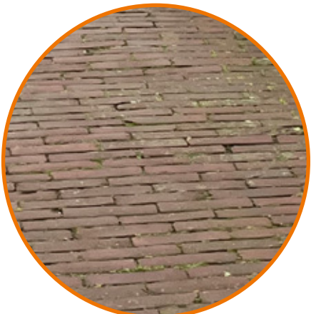
Hergebruik gebakken steen
