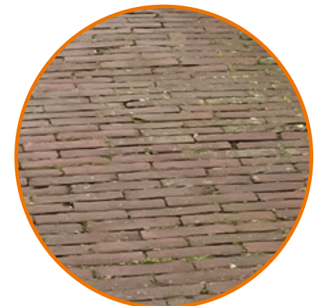
Hergebruik gebakken steen - trottoir
